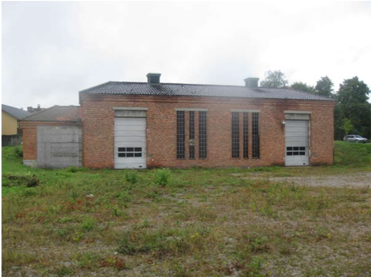
Bild 5: Gamla Kraftstationen. Foto M. Vallström
